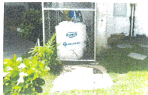
(ช) ระบบฆ่าเชื้อโรคด้วยคลอรีน
